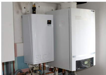
Warmtepomp (links) en cv-ketel (rechts): klaar voor gebruik
