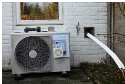
De buitenunit plaatsen
