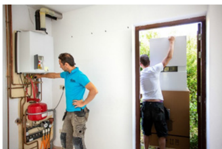
De warmtepomp wordt binnengebracht, cv-ketel hangt er nog.
