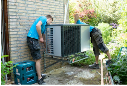
Het plaatsen van de buitenunit. Hierin zit een ventilator die warmte uit de lucht haalt.
