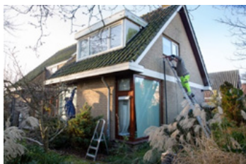
Gaten boren in de voegen
