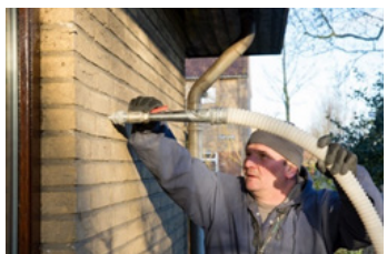
Gaten vullen met isolatiemateriaal
