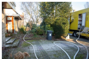
Vulmateriaal gaat door lange slangen naar de muur
